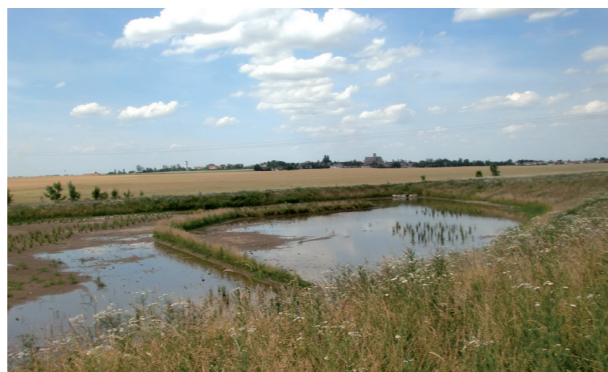
L'un des 4 aménagements auto-épurateurs de Rampillon (77)
