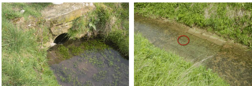
Figure 59 : Le déversoir en bois sur la source Pecqueux (à gauche) et le capteur fixé sur les dalles sur le ru d'Avon (à droite)
