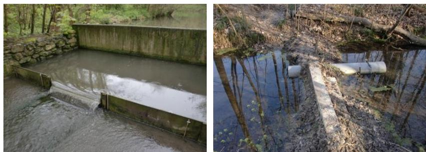
Figure 52 : Le déversoir en bois sur le ru Bobée (à gauche) et le tuyau dans lequel s'écoule l'eau de la source Jouvence (à droite)
