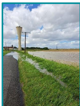
Des sols et fossés gorgés d'eau sur le bassin versant de l'Ancoeur le 2 août
