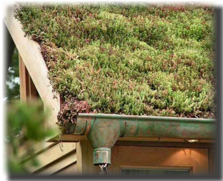
Le toit végétalisé est un régulateur de débit et va se comporter comme une éponge. L'eau va s'infiltrer dans la végétation. Cela peut rester d'ailleurs le seul apport d'eau à réaliser. Pour des fortes pluies, le débit sera écrêté, et une partie des eaux sera stockée.
