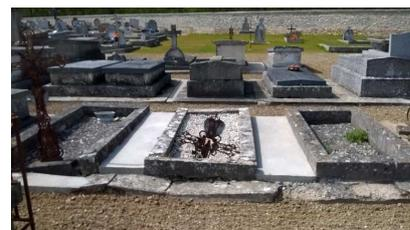
La végétalisation n'a pas réglé le problème des inter-tombes et tombes abandonnées, c'est pour cela que M. Bassile reprend les maçonneries des bordures de tombes en réalisant une chape béton. Pour les tombes abandonnées, le projet est en cours de réflexion au sein de la commune.
