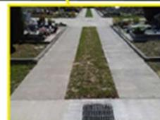
Bande de roulement en béton sur allée principale avec noue végétale pour récupération des eaux pluviales
