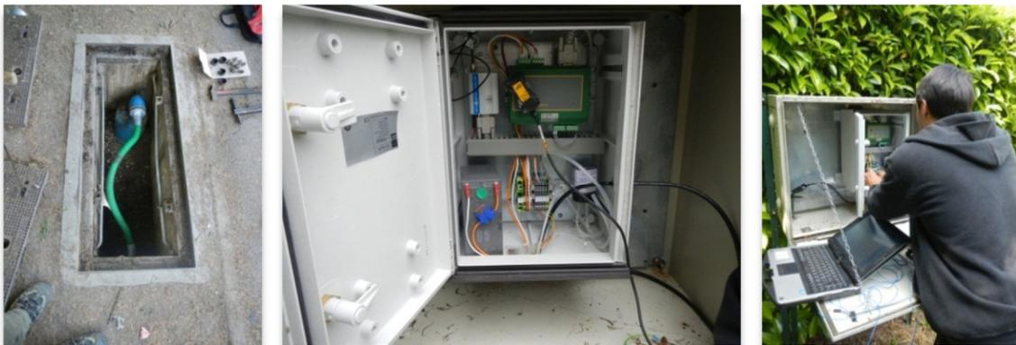
Figure 4 : Le site de Champdeuil avec la cloche étanche où passe la sonde OTT PLS (à gauche), le caisson étanche avec la station d'enregistrement (au centre) contenue au sein de l'armoire métallique extérieure (à droite).
