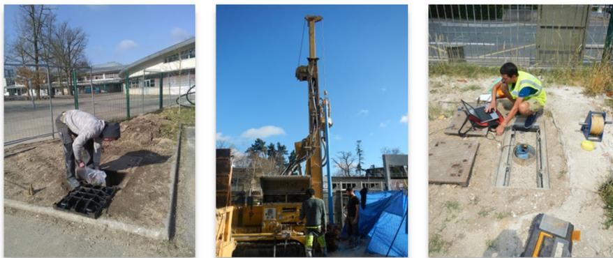
Figure 5 : Comblement du piézomètre de Dammarie-les-Lys les 21-22 mars (à gauche), foration du nouveau piézomètre 50 m plus loin par SETRAFOR les 28-29 mars (au centre), mise en place de l'appareil de mesure après la pose du regard bétonné et de ses plaques métalliques le 26 juillet (à droite).
